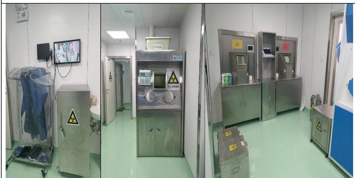
高活室监控系统、铅保险柜、应急去污箱、手套箱、铅废物桶、套娃废物箱等
