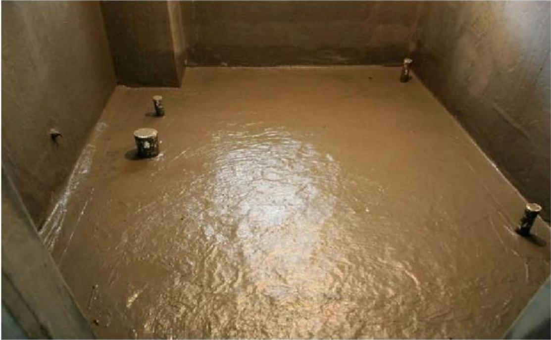
2、管线穿楼板根部，加强防水。管根建筑密封膏封严，水泥磨平滑护脚后，刷防水涂料时贴玻璃纤维布加强层 1—2 层。地漏附近同样措施。
