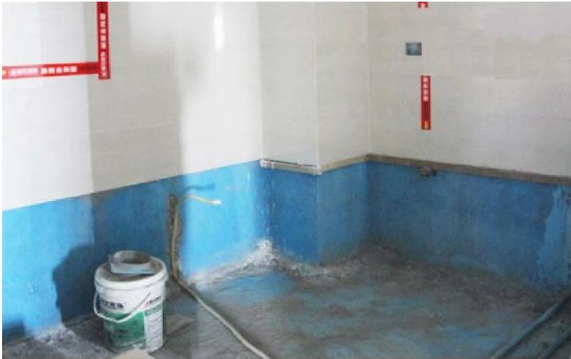
5、地面防水层应涂刷出卫生间门口以外 300 宽。地面防水层应高出地面 200，有淋浴的卫生间墙面防水层应高处地面 1.8 米。
